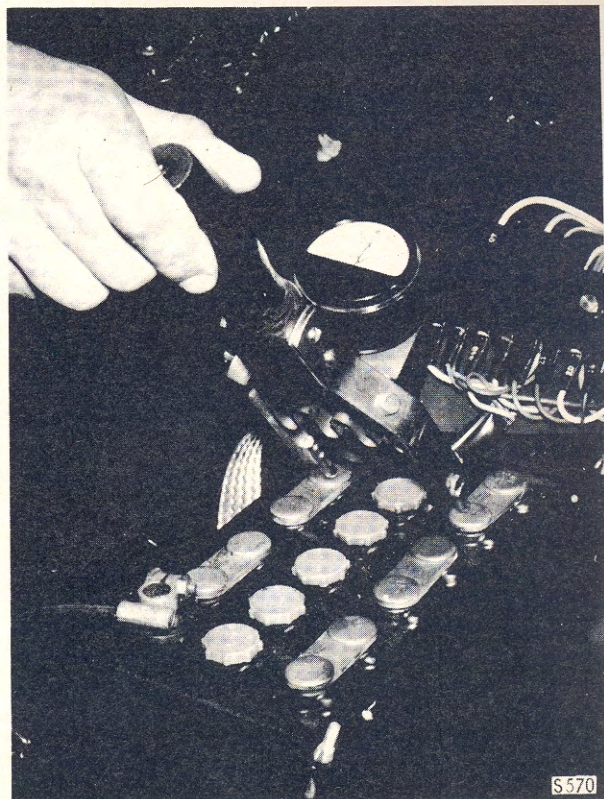
PROVNING AV BATTERI MED CELLPROVARE
